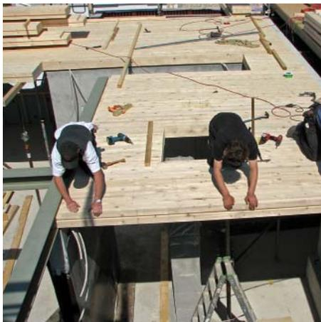
**ABB. 7** Brettstapeldecken wie hier aus Weißtanne stellen nach Einschätzung des Verbundes STARKHOLZ eine ökologisch und ökonomisch attraktive Alternative zu Beton und Stahl dar – man kann sagen: »Ein rundum gelungenes Produkt aus Starkholz!«
